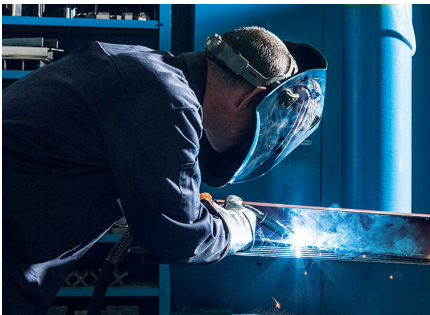
Manual MIG welding
